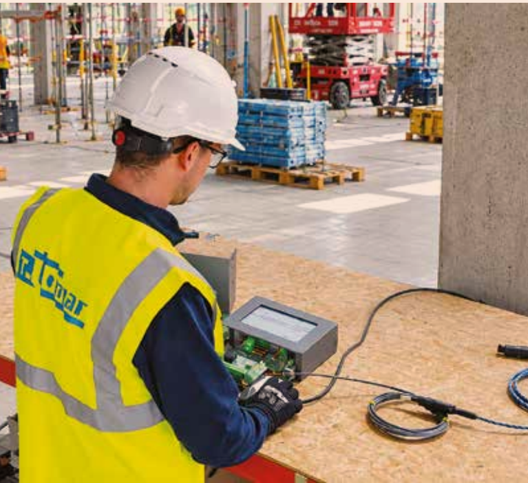
Un tecnico Temar durante le verifiche di un sistema in cantiere.
