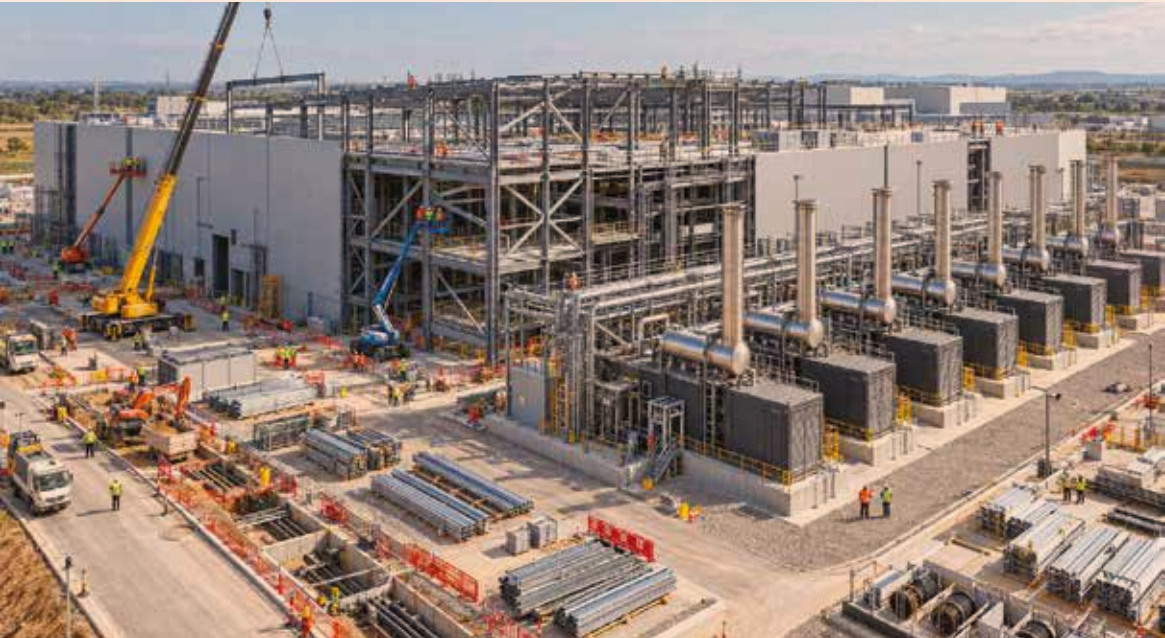
Data Center Hyperscale in costruzione
