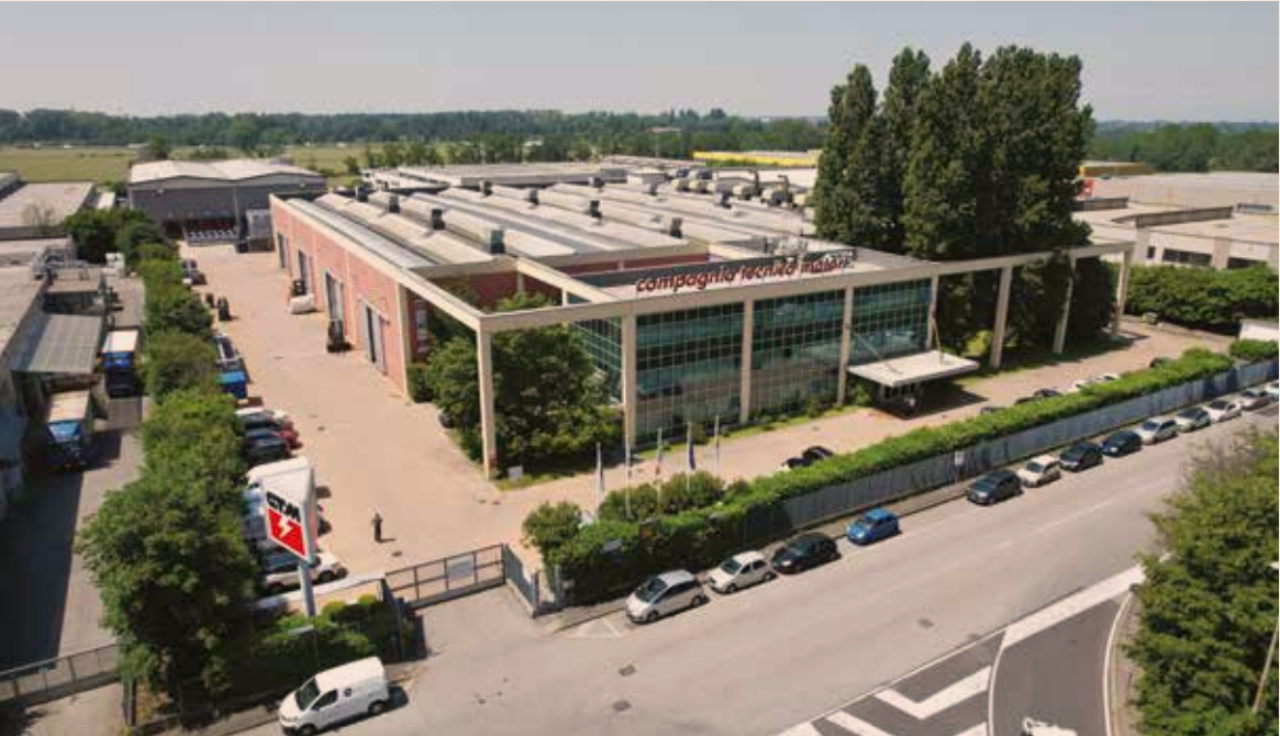
Compagnia Tecnica Motori - Sede e Stabilimento a Cesano Boscone (MI)
