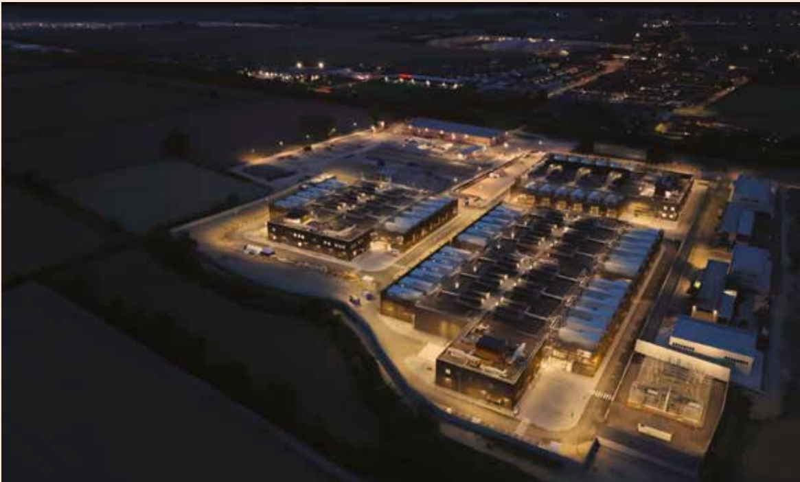
La generazione di emergenza CTM al servizio di un campus data center
