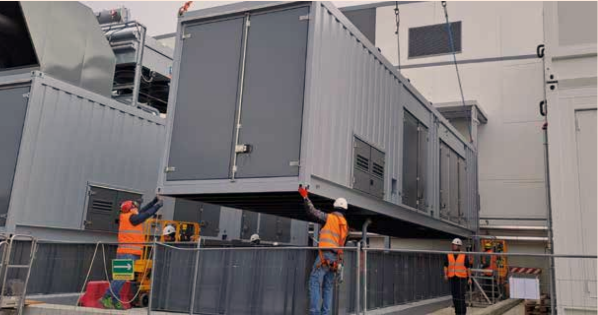
Operazioni di sollevamento e posa in opera di gruppi elettrogeni CTM presso un datacenter
