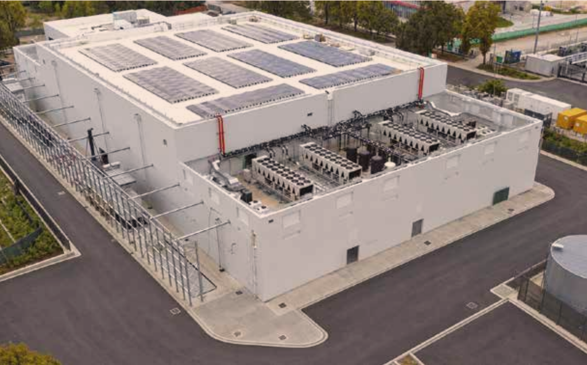
Esterno del data center
