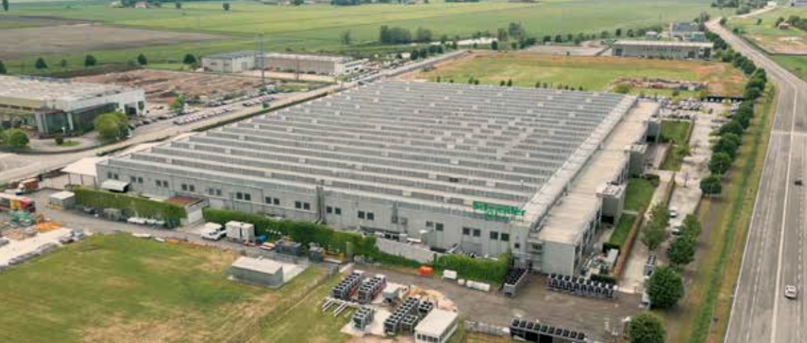
Il centro di eccellenza europeo per le tecnologie avanzate di raffreddamento Schneider Electric a Conselve (PD)
