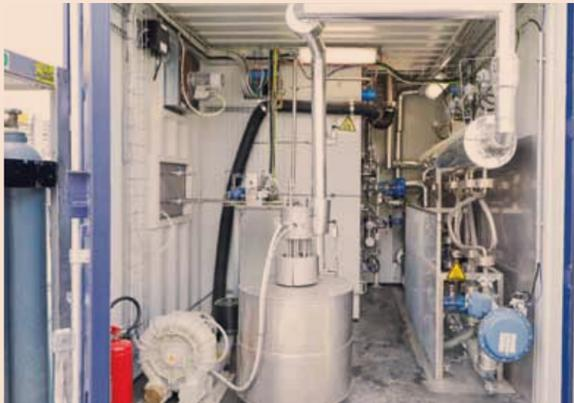
Impianto pilota di metanazione per la produzione di metano sintetico da idrogeno e CO2 presso centro di ricerca ENEA-Casaccia
