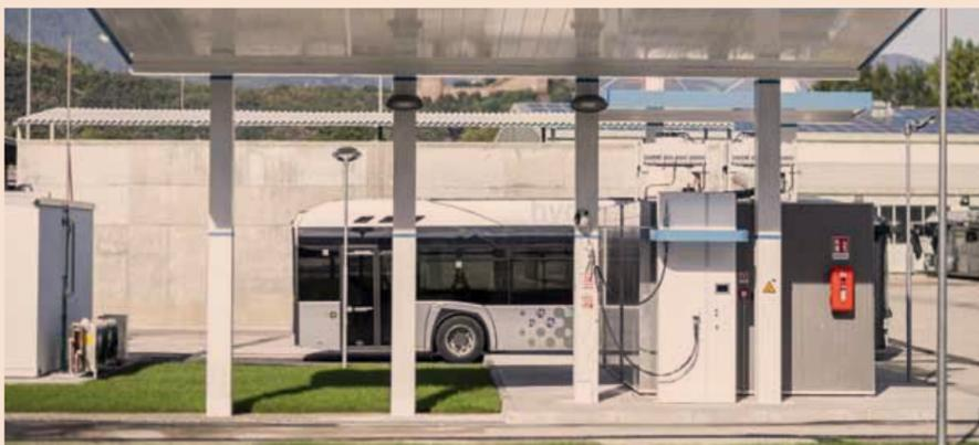
La stazione di rifornimento di Sasa. Il rifornimento dei bus avviene a 700 bar. Nei prossimi anni la stazione di rifornimento sarà ampliata per rispondere alle nuove esigenze dell'azienda di TPL
