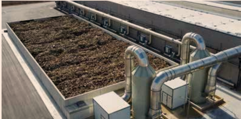
Impianto di biostabilizzazione dei Rifiuti Solidi Urbani e produzione di compost da rifiuti organici
