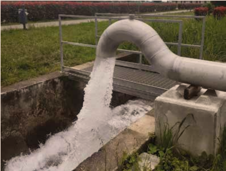
Pozzo n°14 di Caravaggio (BG) - Nuova tubazione con sistema a collo d'oca, che recapita l'acqua nella Roggia Rognola, ramo Morletta. Il collo d'oca assicura una gestione ottimale del flusso idrico, riducendo turbolenze e colpi d'ariete, garantendo al contempo una transizione fluida e stabile dal sistema di sollevamento al punto di recapito
