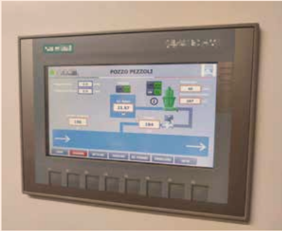
Pozzo Pezzoli in comune di Zanica (BG) - Pannello display touch del quadro di telecontrollo, che mostra in tempo reale i dati relativi alla portata emunta, al livello dinamico (colonna d'acqua sopra l'elettropompa sommersa), alla frequenza e alla potenza di esercizio
