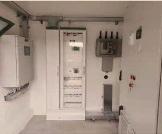
Pozzo Valere in comune di Mornico al Serio (BG) - Da sinistra a destra: nuovo quadro di telecomando e telecontrollo a servizio del pozzo, quadro di bassa tensione e quadro di avvio dell'elettropompa, dotato di inverter per la regolazione dei parametri di funzionamento della pompa
