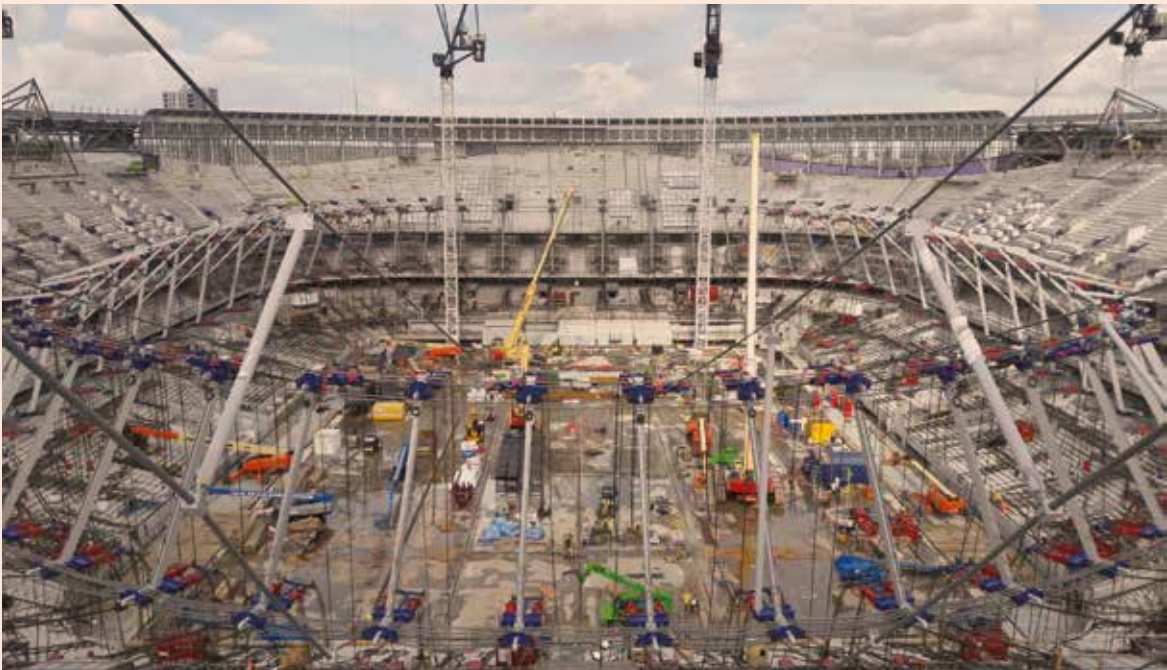
Operazioni di sollevamento della copertura dello stadio del Tottenham Hotspurs
