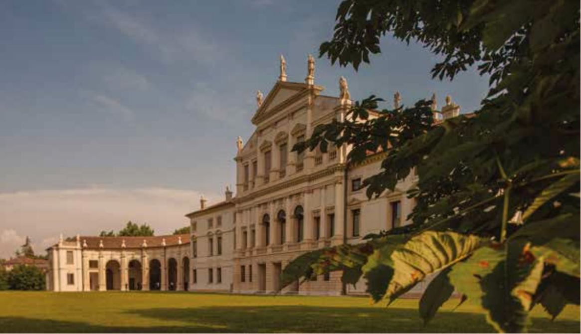
Villa Valmarana Morosini, una sede d'eccellenza per la scuola di management di più antica tradizione in Italia
